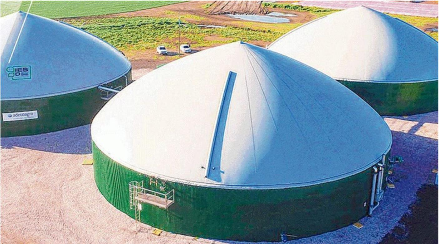
Foto: Biodigestor/ **Adecoagro** transforma el estiércol de los tambos en biogás, electricidad y biofertilizantes.
